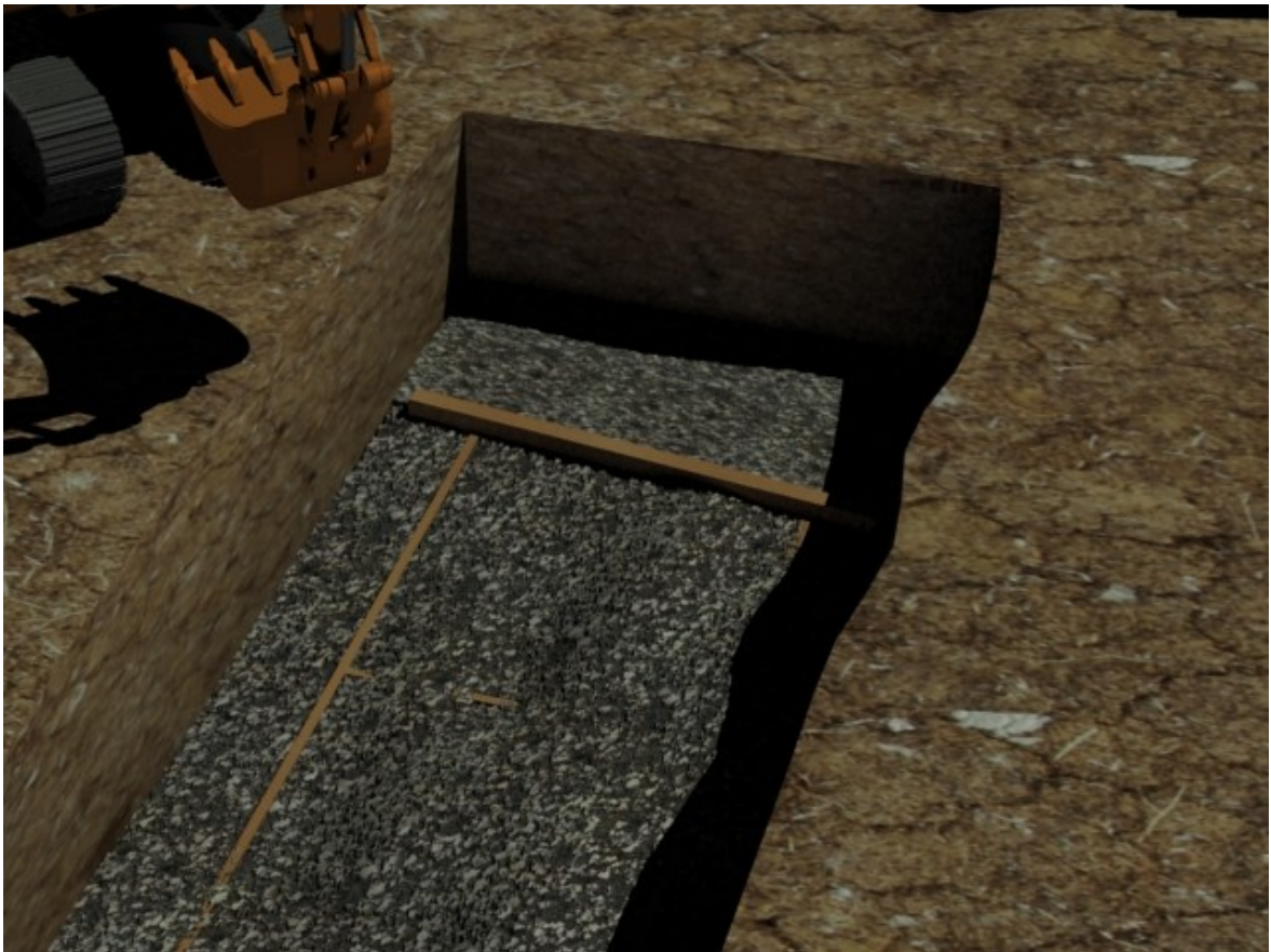
Застелание стен геотекстилем
