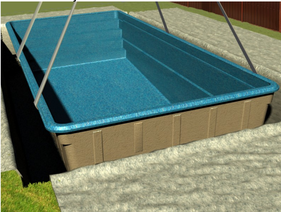
Окончательная установка чаши
